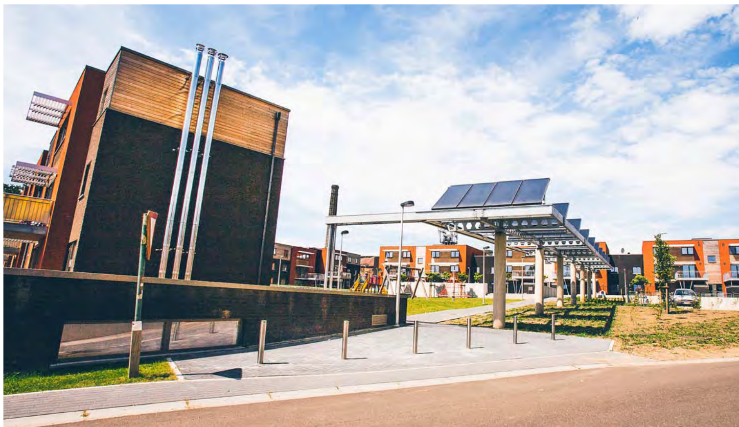
De Schacht - Heusden-Zolder
