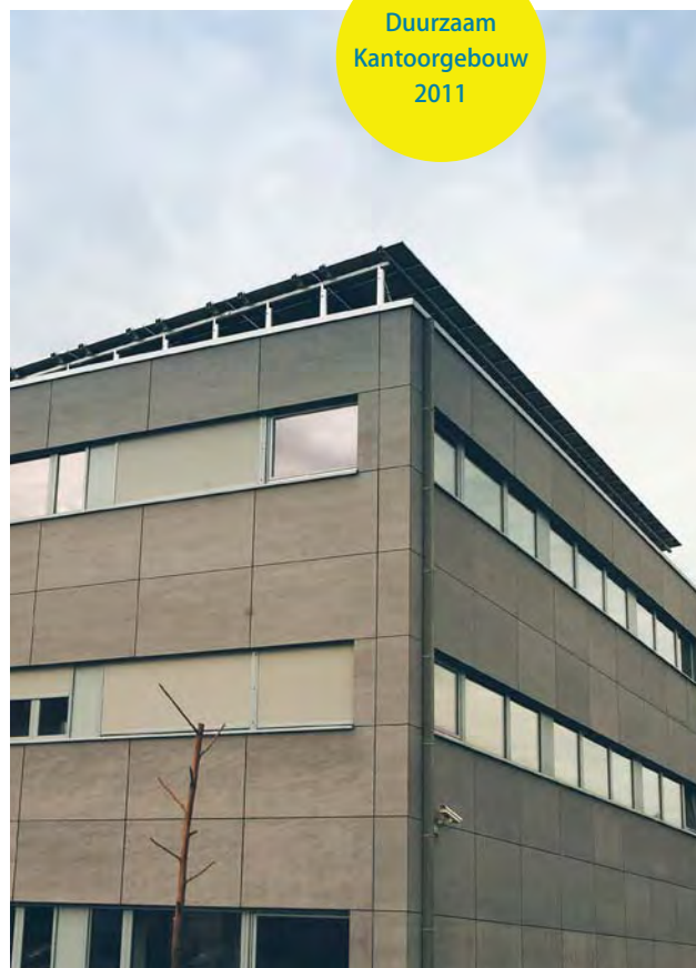
Kantoorgebouw Solar Company - Heusden-Zolder
