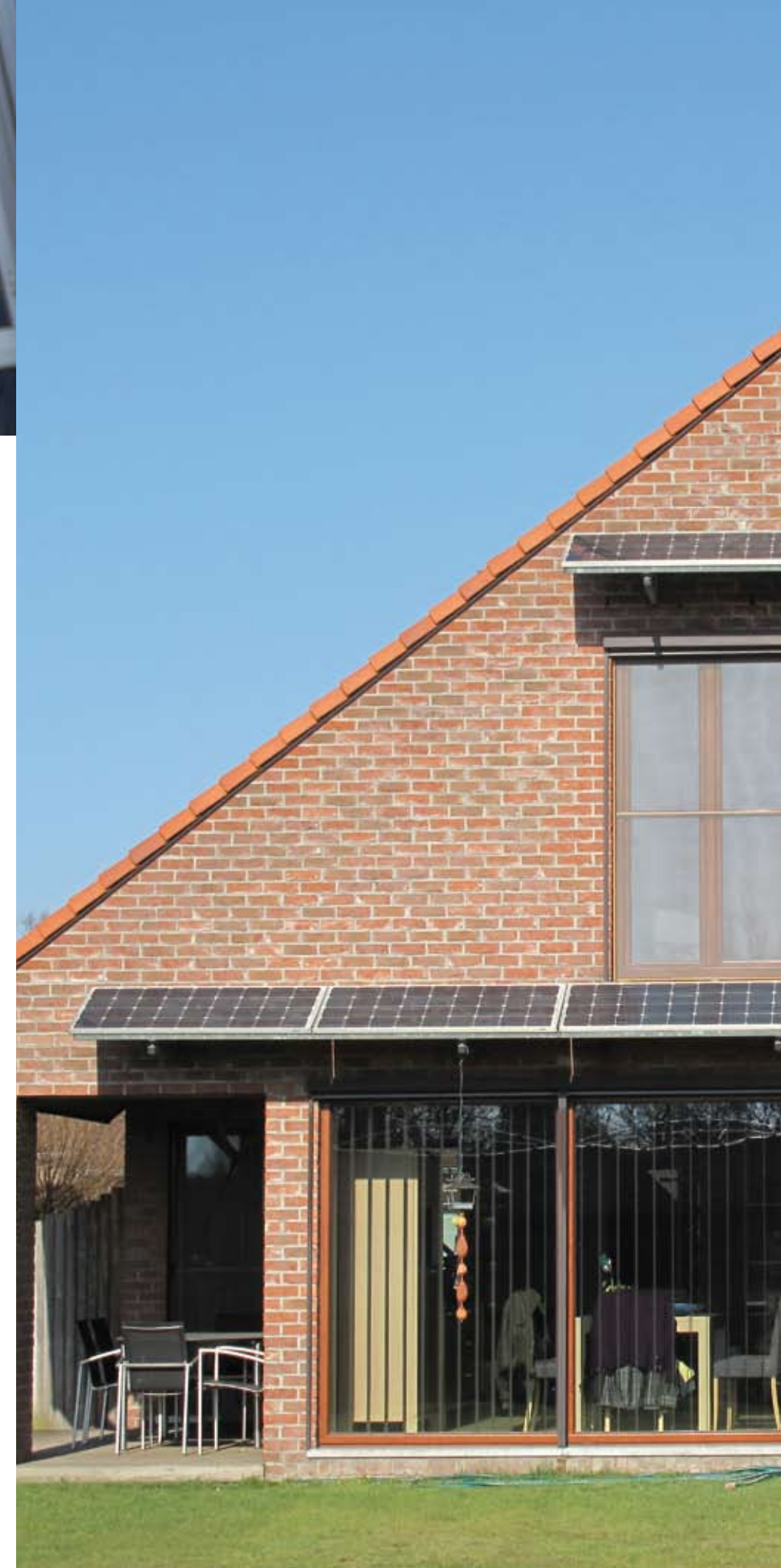
Laagenergiewoning - Spalbeek (Hasselt)
