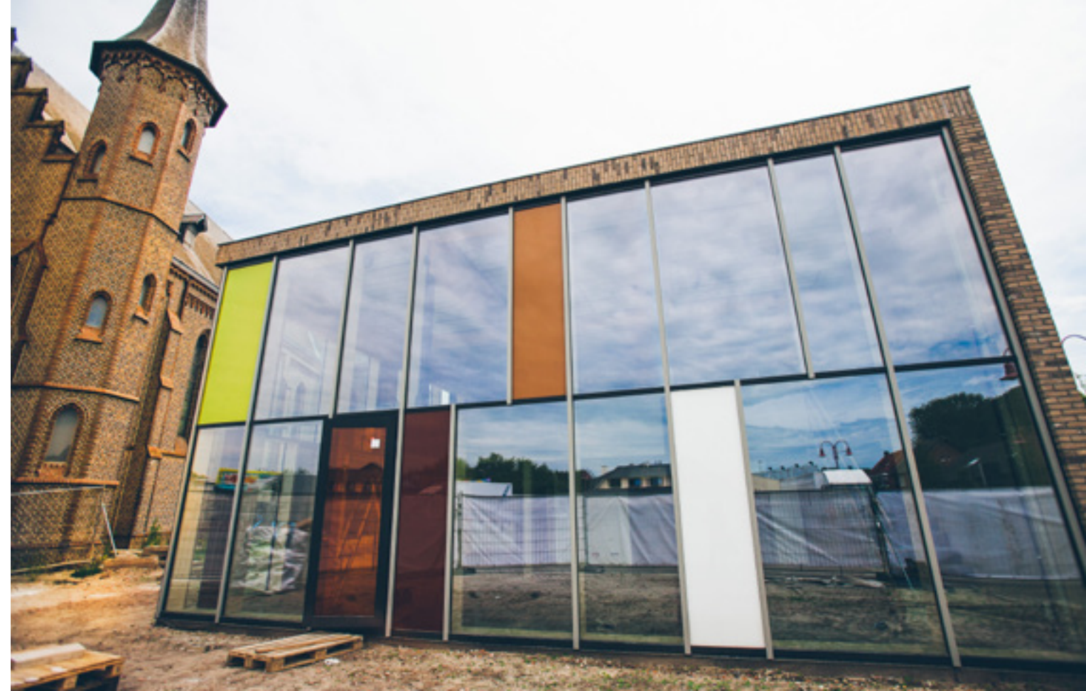
Passiefschool Lozen (Bocholt) wordt voor zowel nieuwbouw als renovatie begeleid door Dubolimborg.
