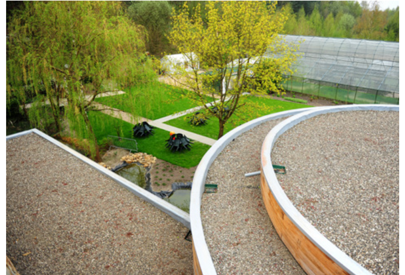
Groendak De Lieteberg (toegangspoort Nationaal Park Hoge Kempen), nieuwbouw
